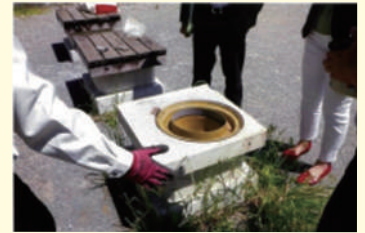
ベンチ式マンホールトイレ
